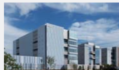
データセンター(岡山第3センタ)
